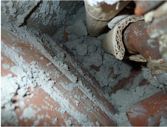
Kuva 11 Rakennuksessa kulkee mm. pystysuuntaisia talotekniikkahormeja, jotka lähtökohtaisesti tulisi purkaa.
