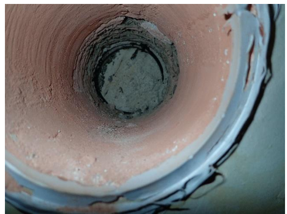
Kuva 4 Itäisivulla maanvastaisella seinällä lämmöneristeenä on Toja-levy. Levyssä on todettu mikrobivaurioita.
