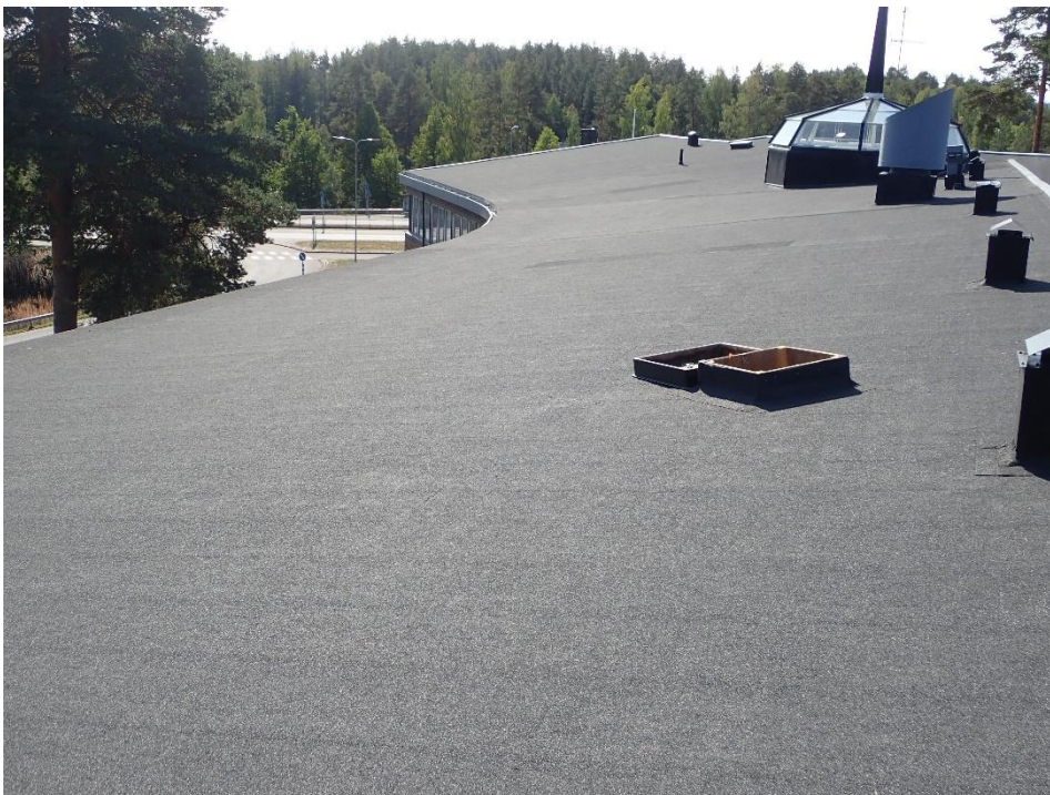
Kuva 24 Yleiskuvaa vesikatolta, vaurioita ei havaittu.
