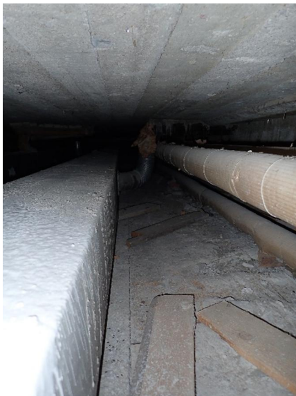
Kuva 9 Yleiskuvaa pohja- ja 1. kerroksen välisestä kotelorakenteesta.
