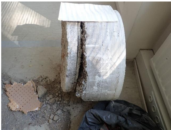
Kuva 7 Yleiskuva pohjakerroksen kaksoislaatasta.
