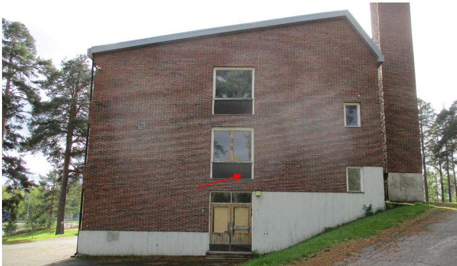
Kuva 1. Pohjoispäädyn ikkunan alla on levyrakenteinen ulkoseinä.
