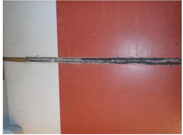
Kuva 12 Rakennuksessa on kaksi liikuntasaumalinjaa
