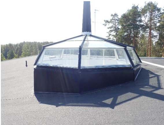
Kuva 22 Yleiskuvaa portaikon kattoikkunasta.
