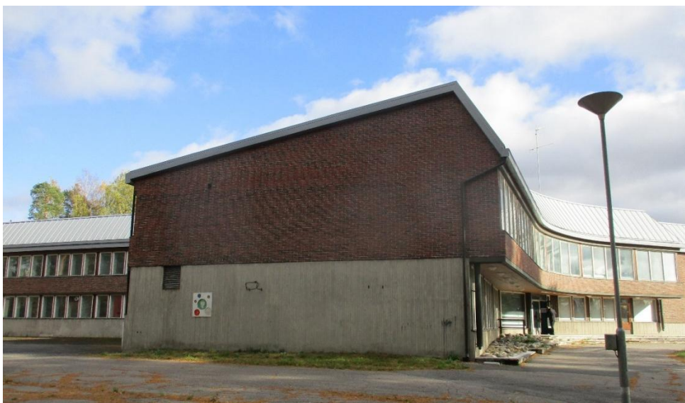
Kuva 2. 1. kerroksen betonisokkelit ulottuvat ikkunan alareunatasoon saakka.
