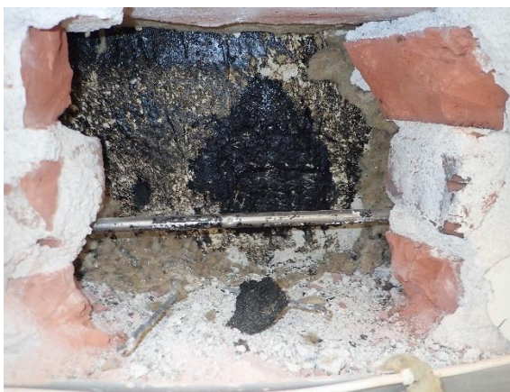
Kuva 3 Eteläisivun maanvastaisessa seinässä lämmöneristeenä on mineraalivilla. Eristetila on tuulettumaton.
