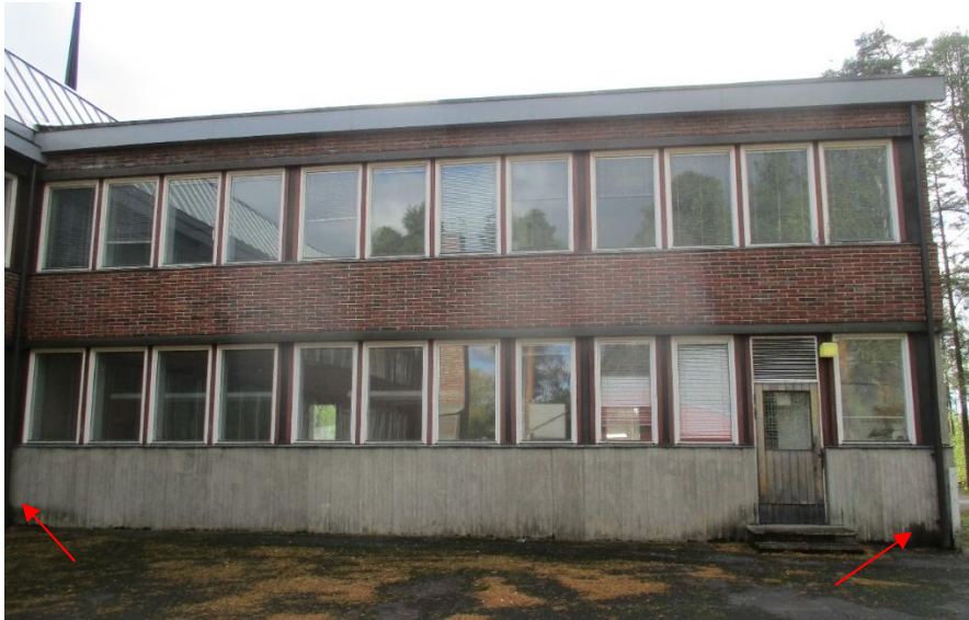
Kuva 3. Sokkelin kastumisjälkiä.
